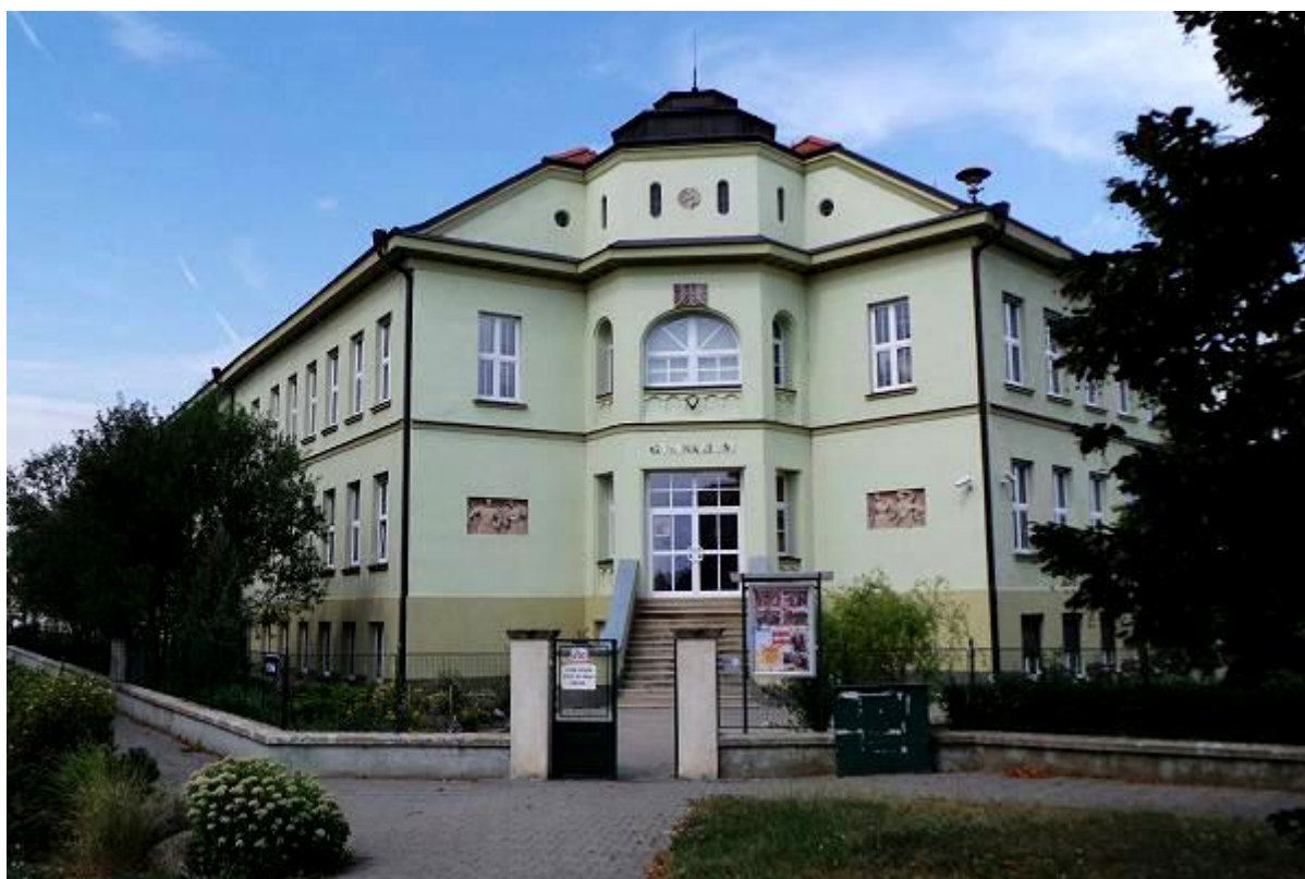
Obr. 2: Budova Gymnázia Židlochovice, příspěvková organizace
