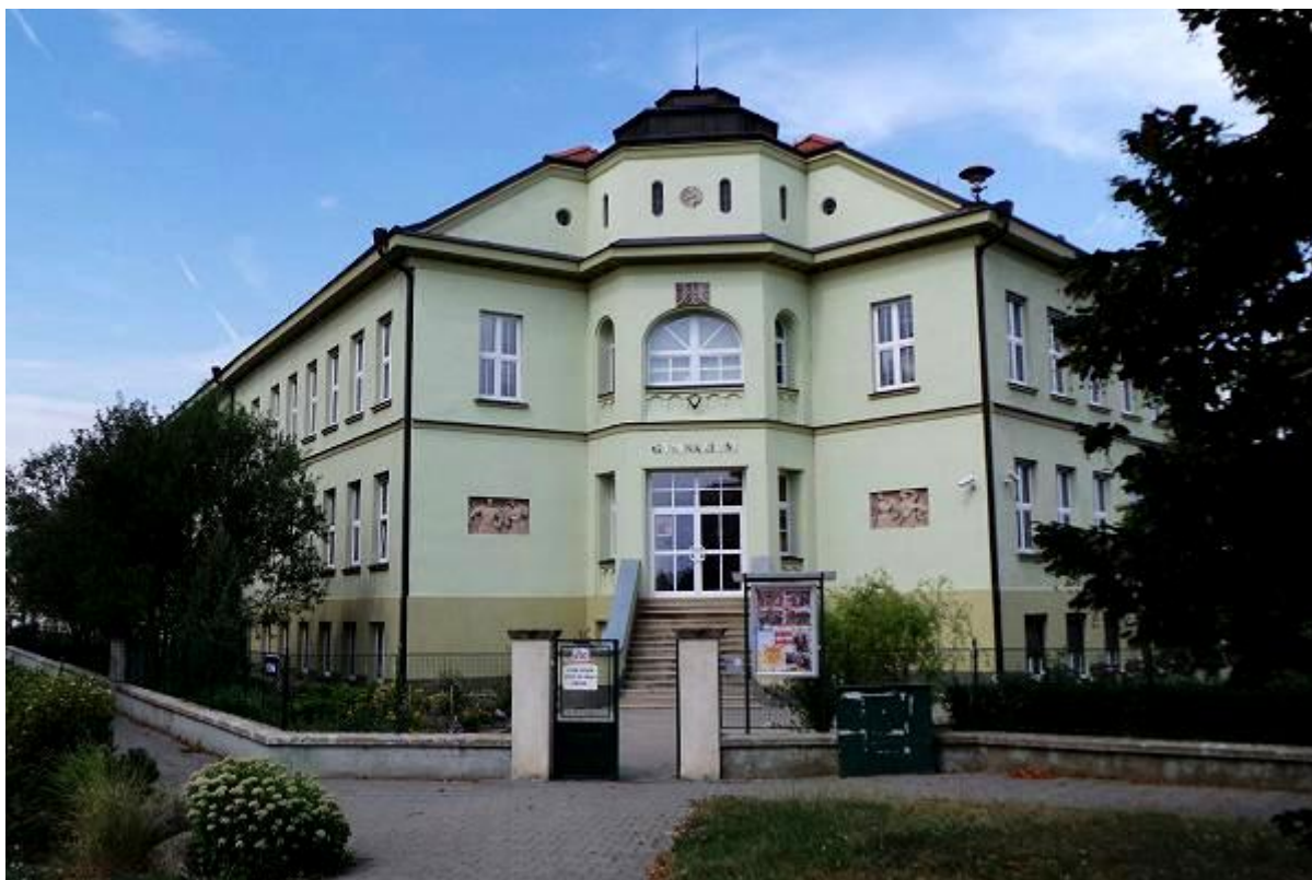
Obr. 2: Budova Gymnázia Židlochovice, příspěvková organizace
